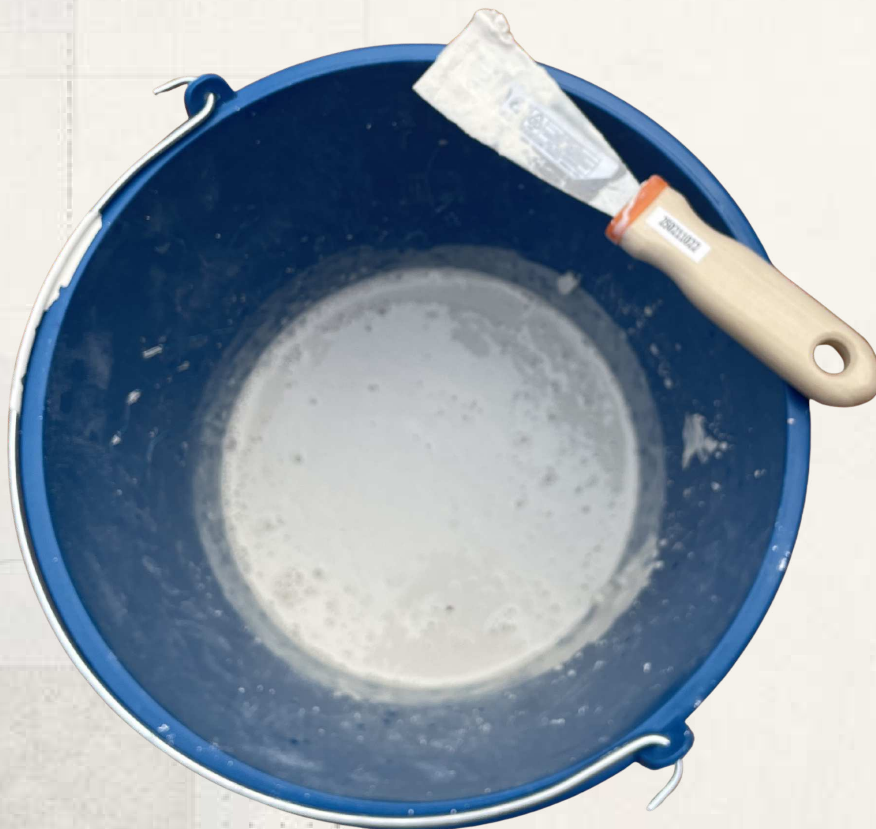
Mezcla del yeso con el agua
